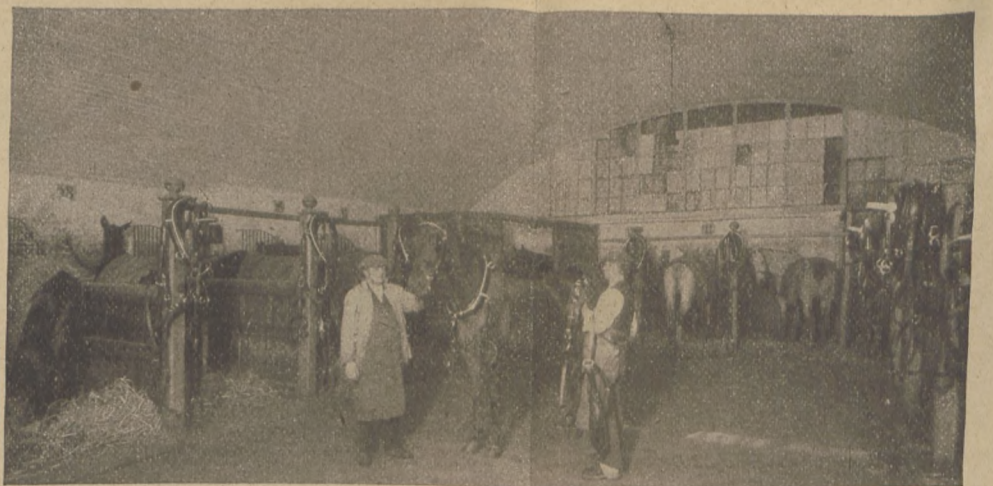
Innenansicht einer der Stallungen.
